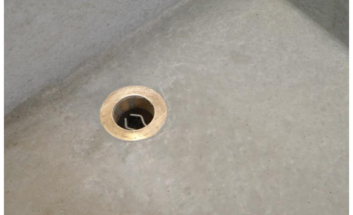
Abflussrohr mit 5/4 Zoll Aussengewinde
